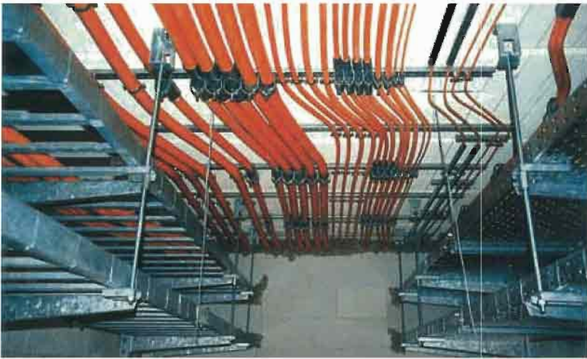
Kabels en draagconstructies worden uitgebreid in eigen huis getest om zo de veiligheid en betrouwbaarheid te kunnen garanderen.
