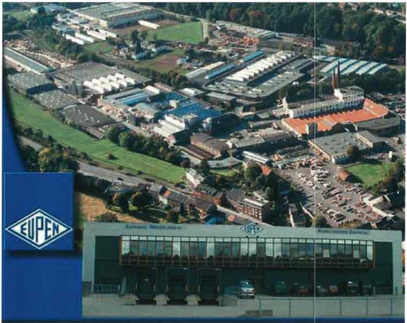
Boven een overzicht van het terrein van Kabelfabriek Eupen in het gelijknamige Belgische plaatsje. Onder een vooraanzicht van het distributiecentrum van Eupendis in Zeewolde.
